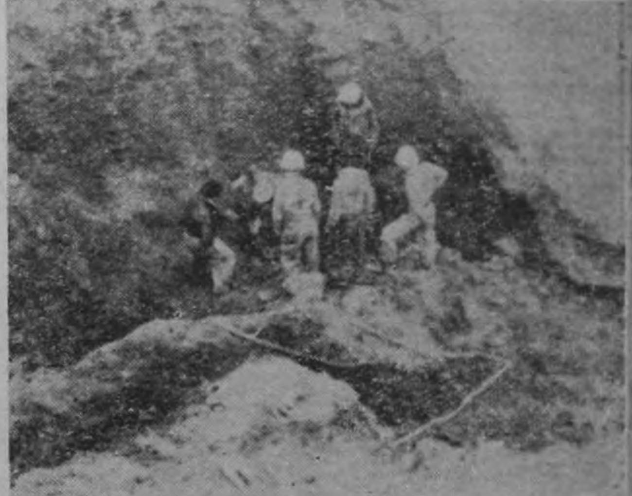
LABOR DE RESCATE:—Un grupo de los hombres que forman la patrulla de rescate, prosiguen con afanosa dedicación, la difícil labor de rescate.
